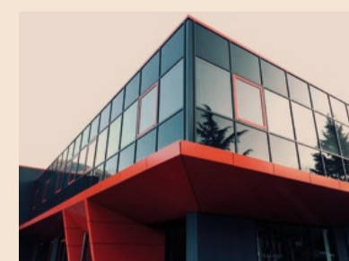
Terrazze dei Tigli" a Riva del Garda (Studio EsseVi Progetti). E inoltre in fase di costruzione l'ampliamento del Salumificio Citterio di Parma. www.orosinfissi.it
